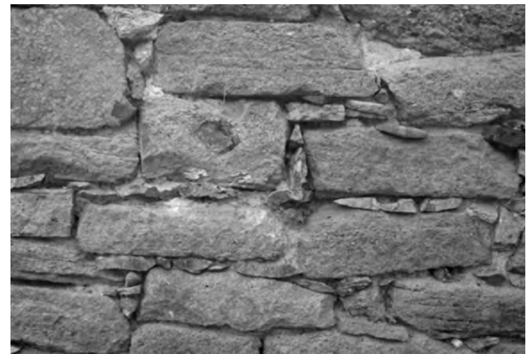
Fotografía 6.- Detalle de los materiales con los que la construyeron.
